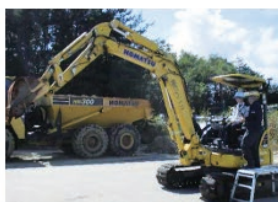
【福島県会場】ICT建機実習
