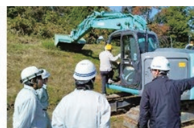
【岩手県会場】ICT建機操作実習
