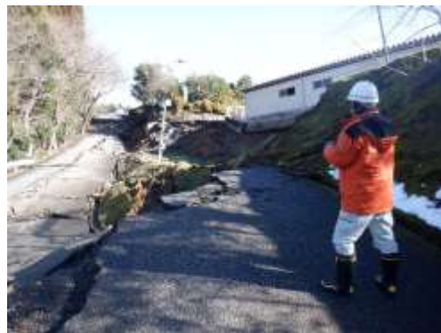
作業状況(UAVによる調査状況)
