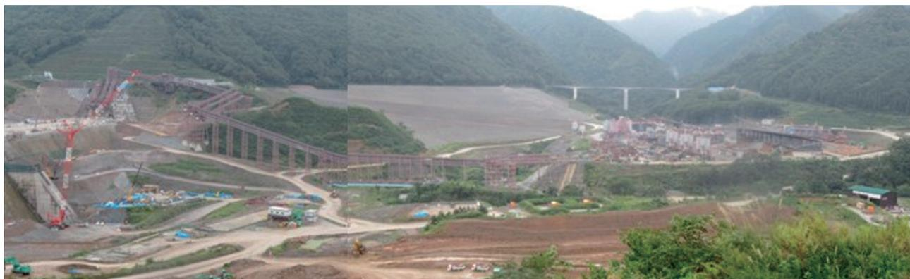
成瀬ダムの現場では、建設機械が無人で自律的にダム提体を築造する自動化施工に加え、令和5年7月からベルトコンベアが稼働、自動化施工を本格化とあわせて提体CSG打設の高度化・安定化を図っています。
