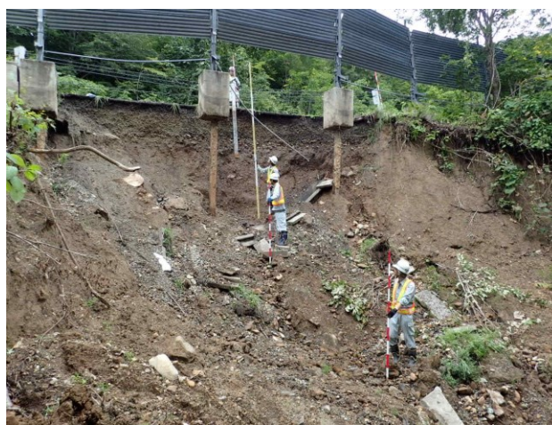
(県道の法面崩壊箇所の調査)
