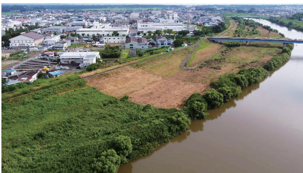
写真：阿武隈川現地（被災想定箇所）状況
